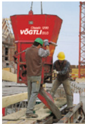
...und Wände mit einem einzigen Kransilo betonieren.
