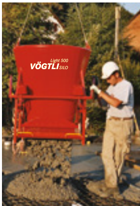
Leichtes und leistungsfähiges Betonieren: bei der Decke ...
